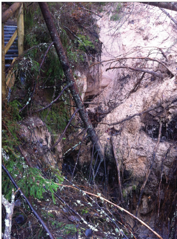
Foto 4. Taevaskoja Emalätte pärast varingut 2013. aasta lõpus. Sisse on varisenud esimene koopaosa, tagumine 0,7 meetrit laiune ja 0,6 meetri kõrgune tunnel on alles. Kristel Vilbaste foto 2013.
